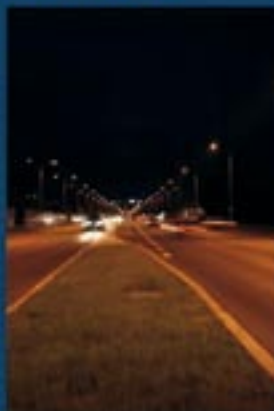
Ulica Sikorskiego po przebudowie
