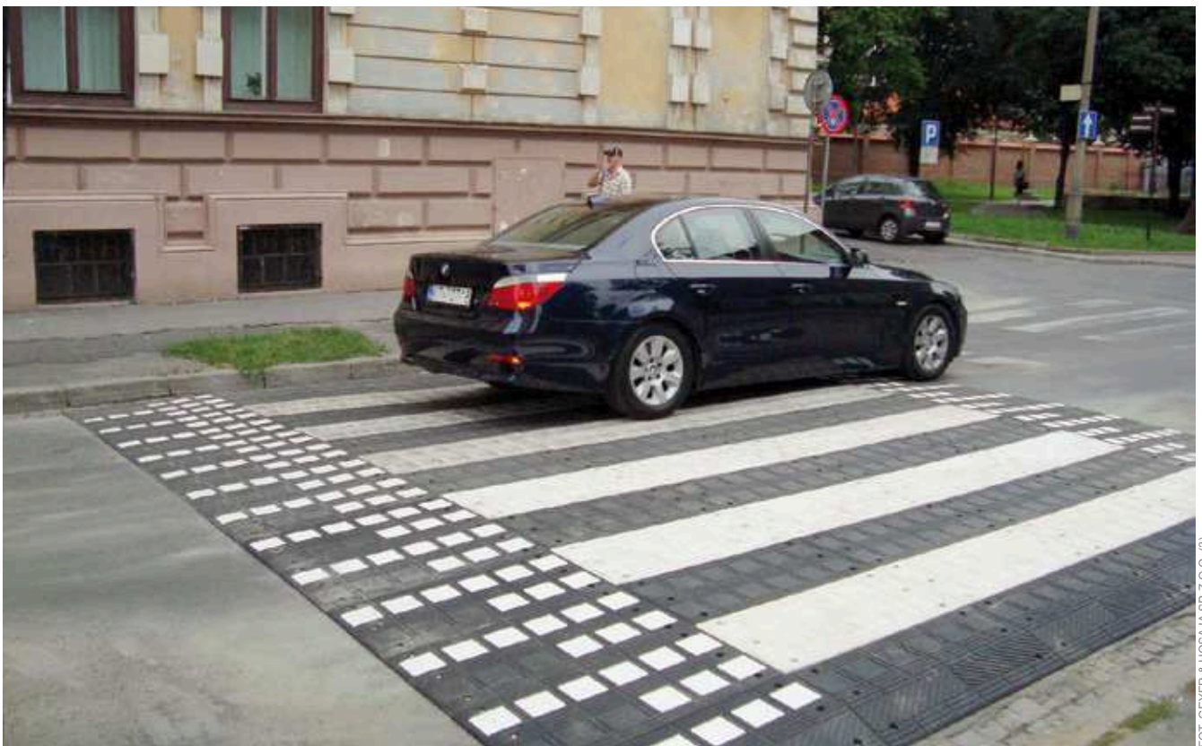
Próg segmentowy z podwyższonym przejściem dla pieszych
