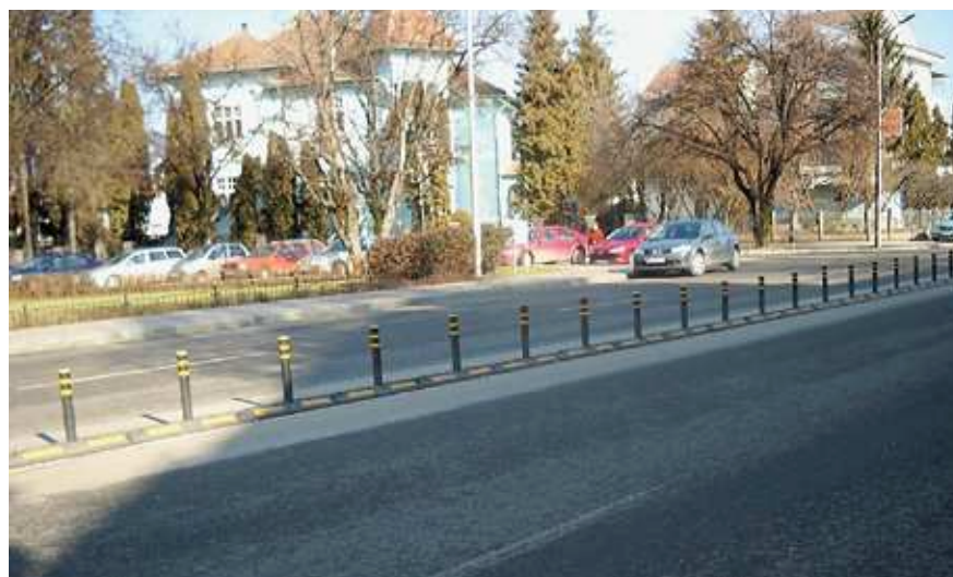
Hol-separator rozdzielający pasy ruchu
