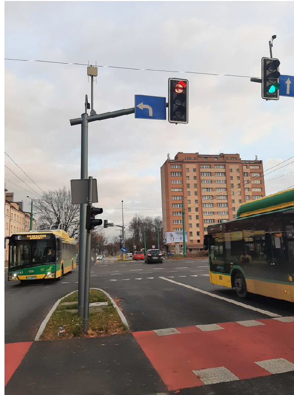
RSU zamontowane na skrzyżowaniu
