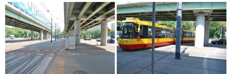
Fot. D.1. Lokalizacja przejazdu tramwajowego bezpośrednio przy skrzyżowaniu z ruchem okrężnym wraz z torowiskiem tramwajowym w pasie dzielącym jezdnie
