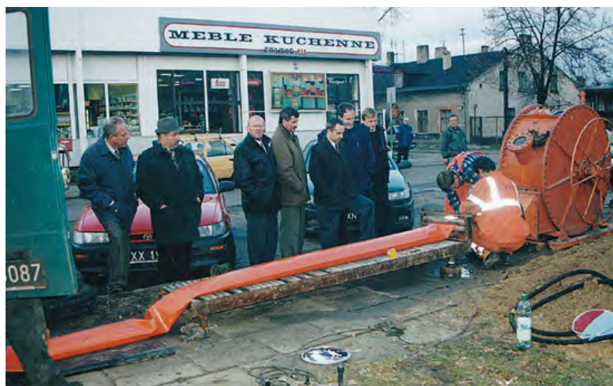
Fot.4 Rekonstrukcja w technologii Phoenix
