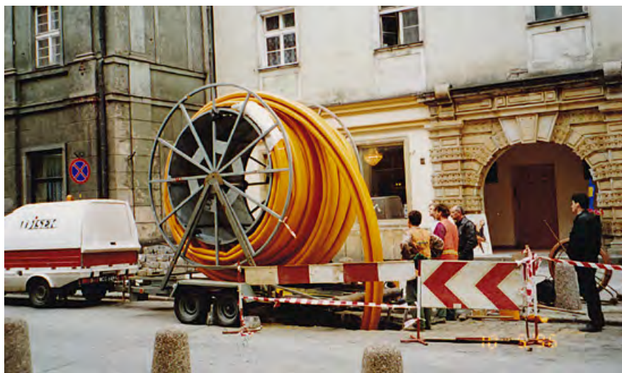
Fot.3 Rekonstrukcja w technologii U-liner
