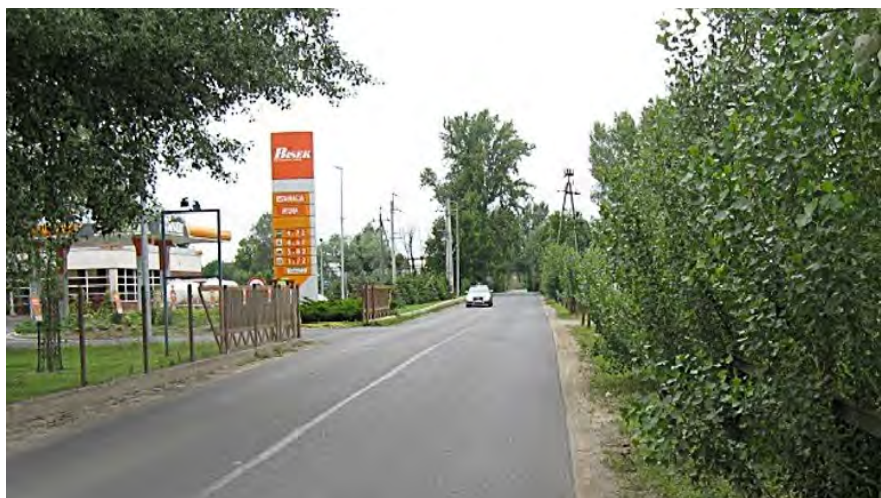
Fot 7. Ulica Macieja Przybyły we Wrocławiu wykonana w technologii asfaltu gumowego
