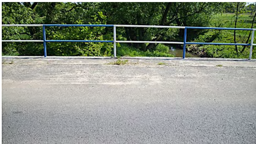
Fot 8. Most w Szczepanowie, gm. Miękinia, asfalt gumowy zastępuje urządzenia dylatacyjne. Stan nawierzchni po 10 latach.
