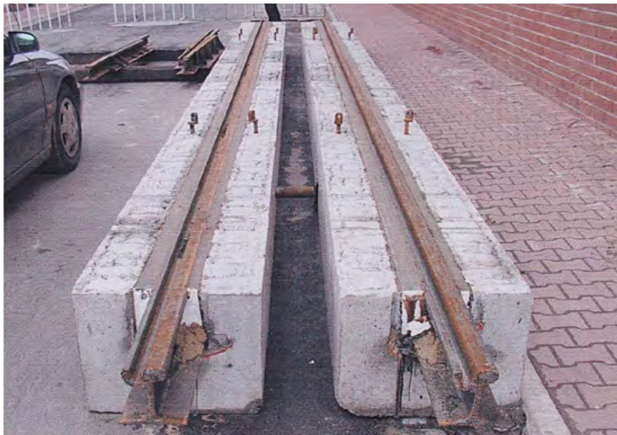
Fot.5 Gotowy prefabrykat konstrukcji torowiska
