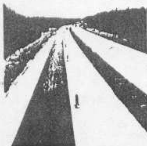
Rys. 18. Pas ruchu z nawierzchnią po regeneracji
