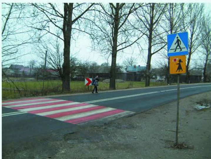
Wielgie dr. woj. Nr 481 –przejście przed szkołą przed przebudową
