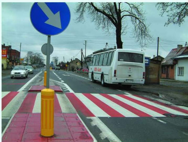
Okup dr. Kraj. Nr 12 –istniejące przejście z zbyt wąską zatoką autobusową
