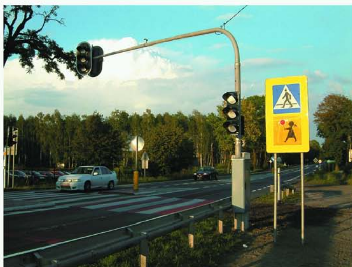
Okup dr. kraj. nr 12– przejście z sygnalizacją wzbudzaną przez pieszych( 2-gi etap przebudowy)
