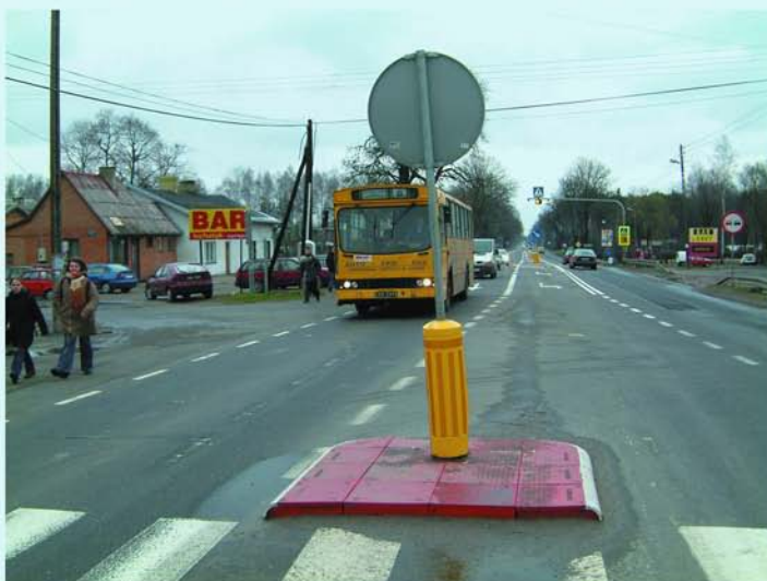
Okup dr.kraj. nr 12–widok na skrzyżowanie dróg powiatowych
