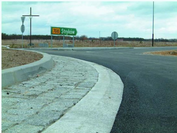
Warszyce- dr. woj. nr 708 / nr 702-pierścień ronda z wylotem w kierunku węzła „STRYKÓW” na A-1/A-2
