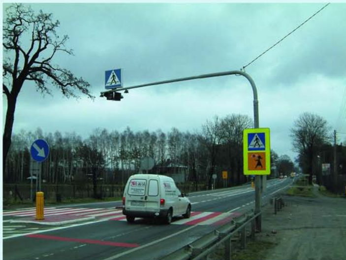
Okup dr. kraj. nr 12 –przeście ze znakiem D-6 (1-szy etap przebudowy)
