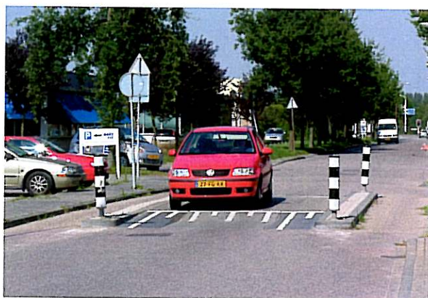
Próg o zmiennym przekroju poprzecznym, różnym dla samochodów osobowych i pozostałych pojazdów.
