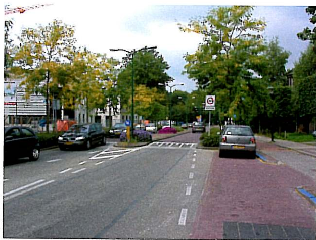
Zmiana przekroju drogi na wjeździe do strefy „30”. Widoczna zmiana profilu drogi.
