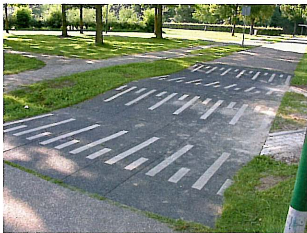
Powierzchnia spowalniająca ruch na drodze rowerowej.
