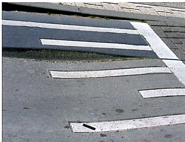
Szczegół konstrukcyjny progów o zmiennym przekroju poprzecznym.
