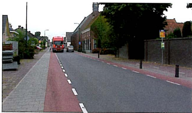
Przekrój drogi regionalnej przechodzącej przez miejscowość (50 km/h).
