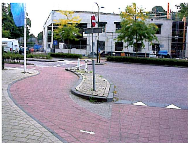
Odgięcie ciągu pieszego i drogi rowerowej na skrzyżowaniu. Widoczne oznakowanie podporządkowania ruchu pojazdów względem pieszych i rowerów.
