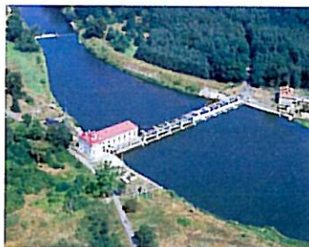
Elektrownia Wodna Szprotawa
