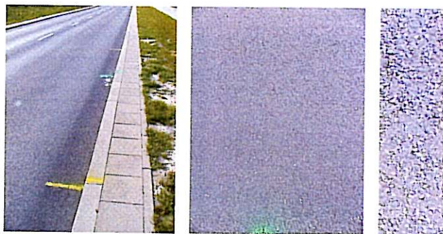
Rys. 13. SMA z kruszywem bazaltowym - obwodnica Bolesławca (rok budowy 2000-2002 - stan 08.2004. Widok miejsca badawczego i widok nawierzchni oraz zbliżenie tekstury.
