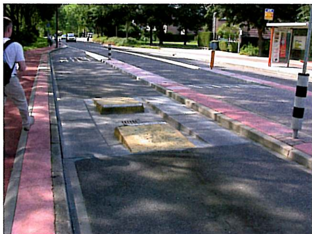
Próg w postaci szyskany na pasie ruchu przeznaczonym wyłącznie dla autobusów.
