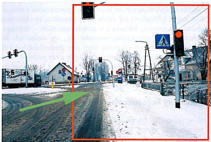
Fot. 1. Dwa pełne zestawy sygnalizatorów umiejscowione w odległości ok. 60 metrów mogą mylić kierujących, choć ich lokalizacja wynika z rzeczywistych potrzeb; w miejscu oznaczonym strzałką jest wylot z osygnalizowanego parkingu
