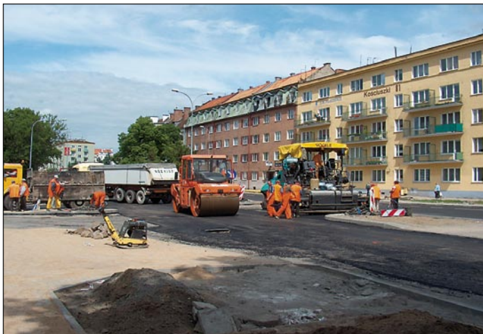
Przebudowa ul. Tadeusza Kościuszki
