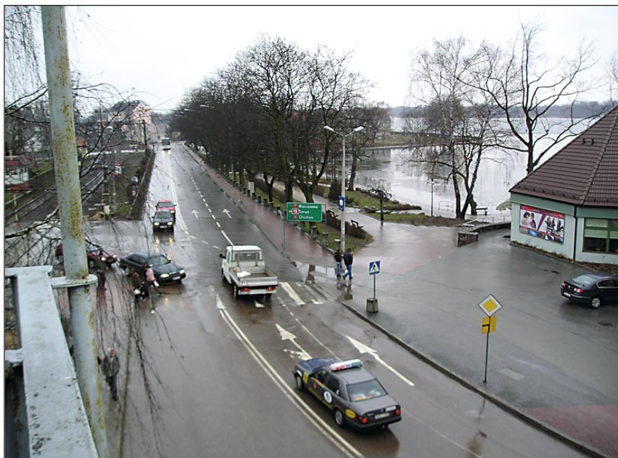
Fot. 1 Przejazdy kolejowe I i II (na pierwszym planie) przed przebudową
