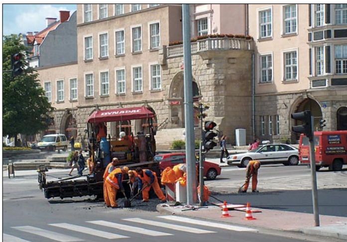
Przebudowa Placu Jana Pawła II
