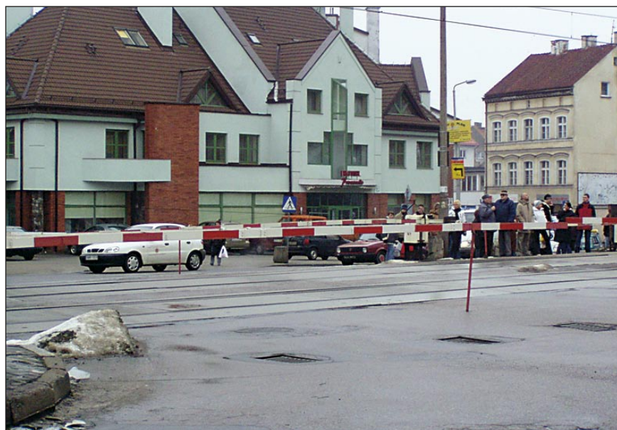
Fot. 3 Przejazd II przy opuszczonych zaporach przed przebudową
