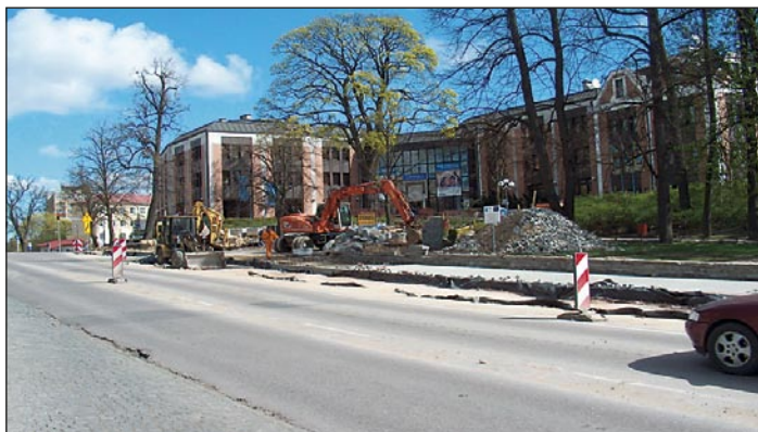
Budowa śluzy komunikacyjnej na ul. 1go Maja
