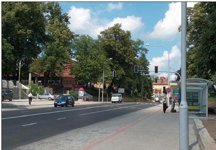
Śluza komunikacyjna po wybudowaniu
