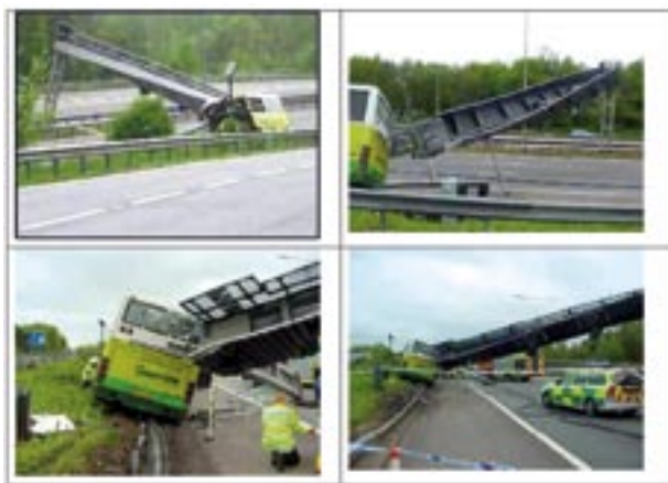
Zdjęcie 1 Zderzenie autokaru z konstrukcją pod znaki zmiennej treści.
