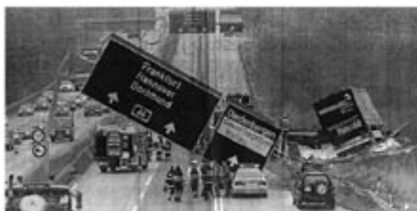
Zdjęcie 2. Zderzenie samochodu ciężarowego z konstrukcją bramową na autostradzie w Niemczech.
