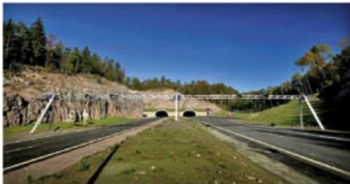
Zdjęcie 7 Instalacja LWG Lattix w Norwegii.
