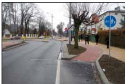
Po lewej : wjazd z pasa dla rowerów na drogę dla rowerów wzdłuż DW 824, po prawej : uporządkowany przekrój DW 824 (m.in. chodnik oddzielony krawężnikiem od drogi dla rowerów).
