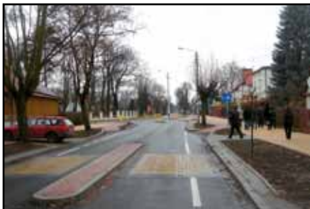
Po lewej : wyniesiona tarcza skrzyżowania czterowłotowego, po prawej : próg przyjazny autobusom.
