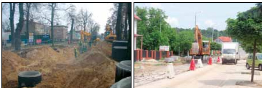
Prace budowlane w toku – po lewej : budowa kanalizacji deszczowej i sanitarnej w drodze nr 824, po prawej : budowa wyniesionej tarczy skrzyżowania ulic lokalnych w dzielnicy Włostowice.
