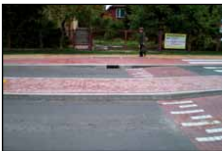
Po lewej : wjazd na wyniesioną powierzchnię skrzyżowania, po prawej : typowy „sinusoidalny” przekrój najazdu na powierzchnię wyniesioną.
