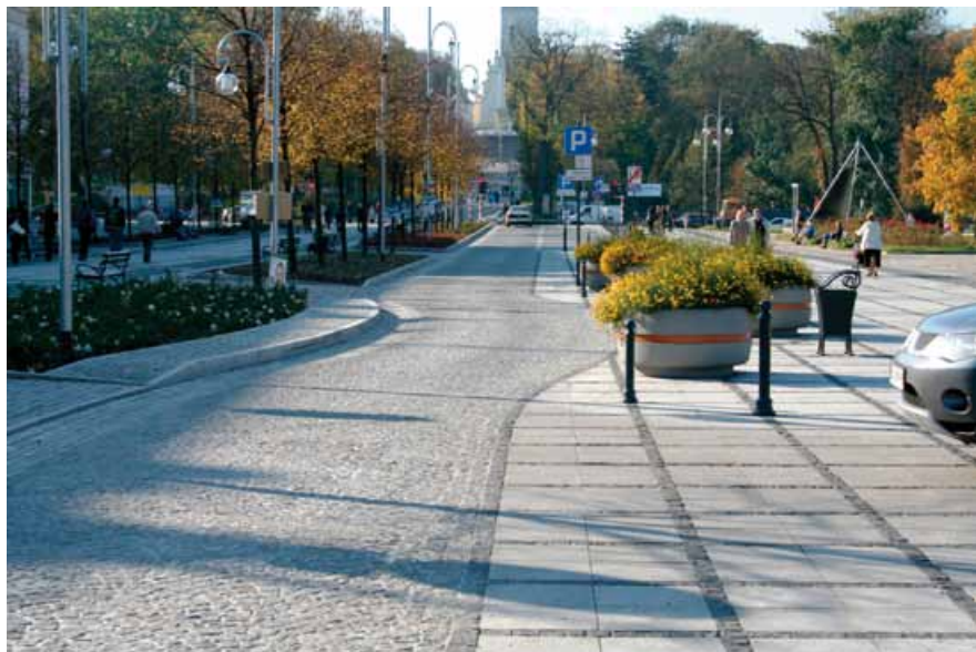
III Aleja po przebudowie
