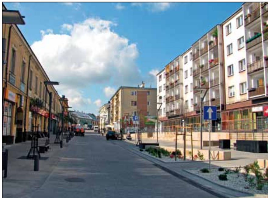
Rys. 14. ul. Warszawska – po rewitalizacji
