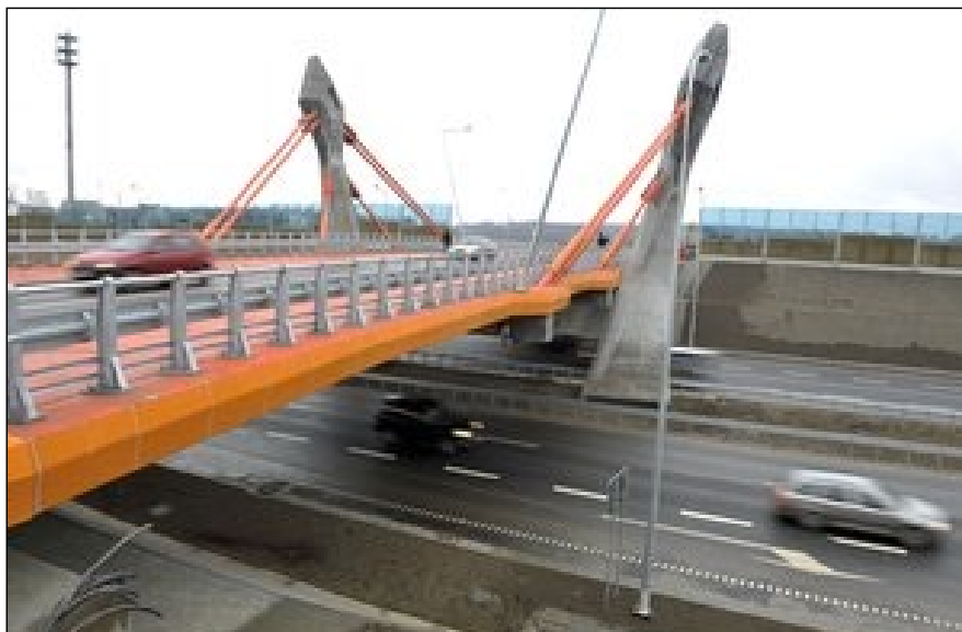
Foto 2. Wiadukt WD6 nad Trasą W-Z
