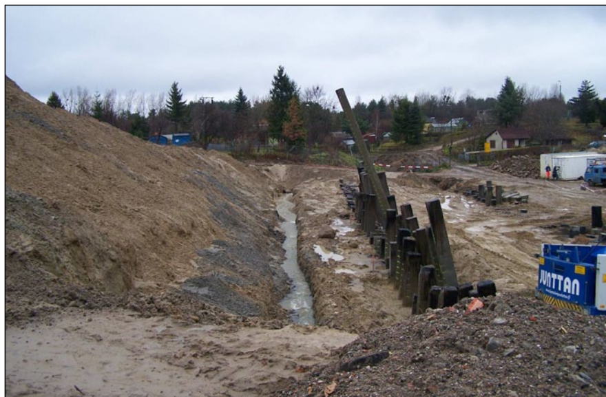
Foto 1 – Roboty palowe PG 4
