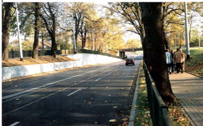
Rys. Przebudowany odcinek ul. Pomorskiej pomiędzy ul. Grunwaldzką i Subisławą
