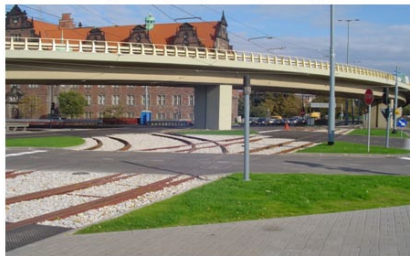
Rys. Przebudowane tory tramwajowe na skrzyżowaniu ulic Powale Przedmiejskie - Okopowa
