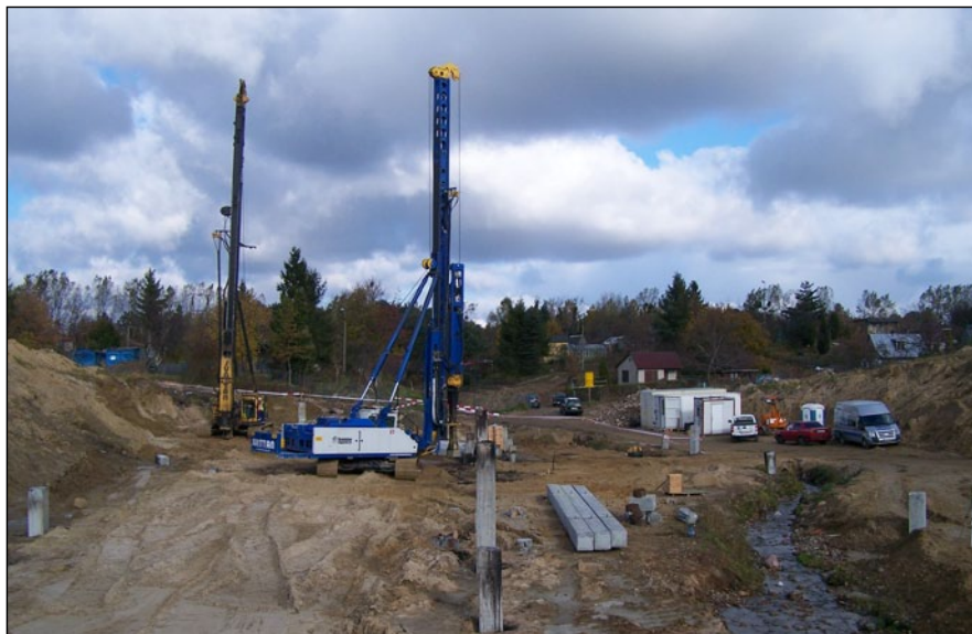
Foto 1 – Roboty palowe PG 4
