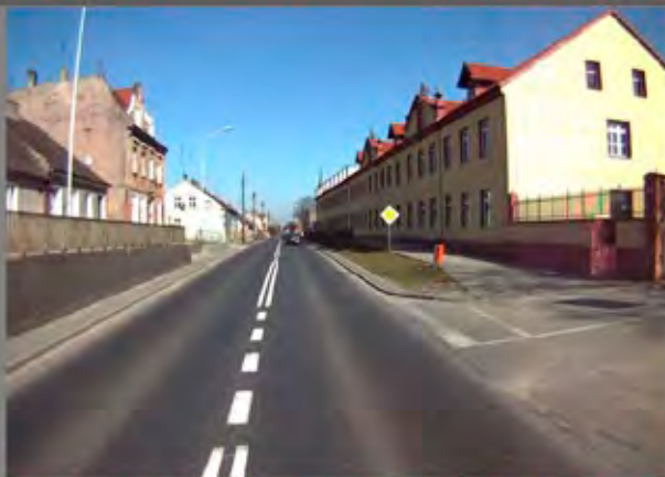
Stan z przed budowy sygnalizacji – dojazd z kierunku Pity
