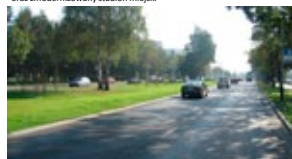
Przebudowana ul. Powstańców Warszawy
