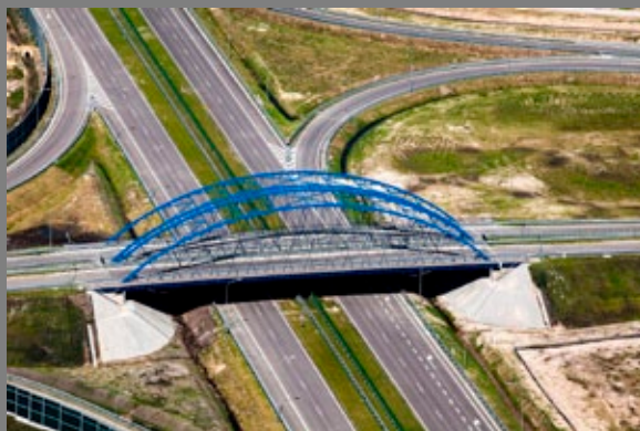
Odcinek autostrady od węzła Dębica Wschód do węzła Rzeszów Zachód – obiekt na węźle Sędziszów
