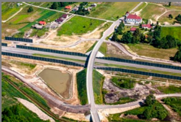
Odcinek autostrady od węzła Dębica Wschód do węzła Rzeszów Zachód – przejazd nad autostradą
