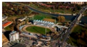
Widok na przebudowaną ul. Powstańców Warszawy oraz zmodernizowany stadion miejski
