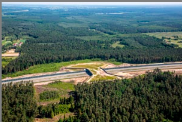
Odcinek autostrady od węzła Dębica Wschód do węzła Rzeszów Zachód – przejście dla zwierząt
