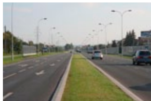
Przebudowana ul. Sikorskiego
