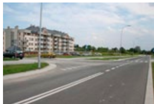
Wybudowana ul. Krogulskiego
