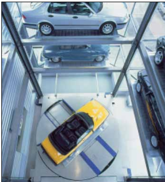
Fot.4 Zwrotnica samochodowa stanowi pomoc w pozycjonowaniu samochodu [6]
