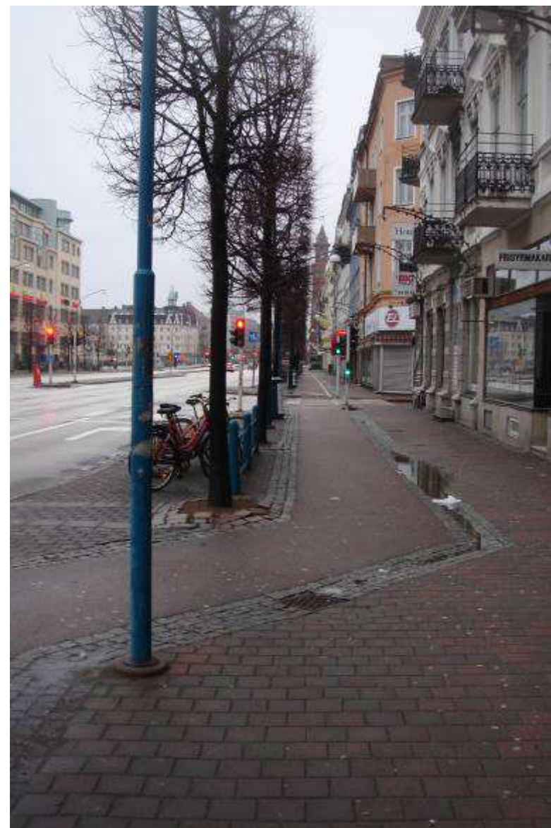
SZWECJA. Przykład spowolnienia rowerzystów przed przejazdem przez wlot poprzeczny (odgięcie toru jazdy).
