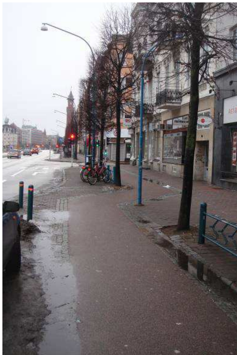
SZWECJA. Przykład spowolnienia rowerzystów przed przejazdem przez wlot poprzeczny (odgięcie toru jazdy).
