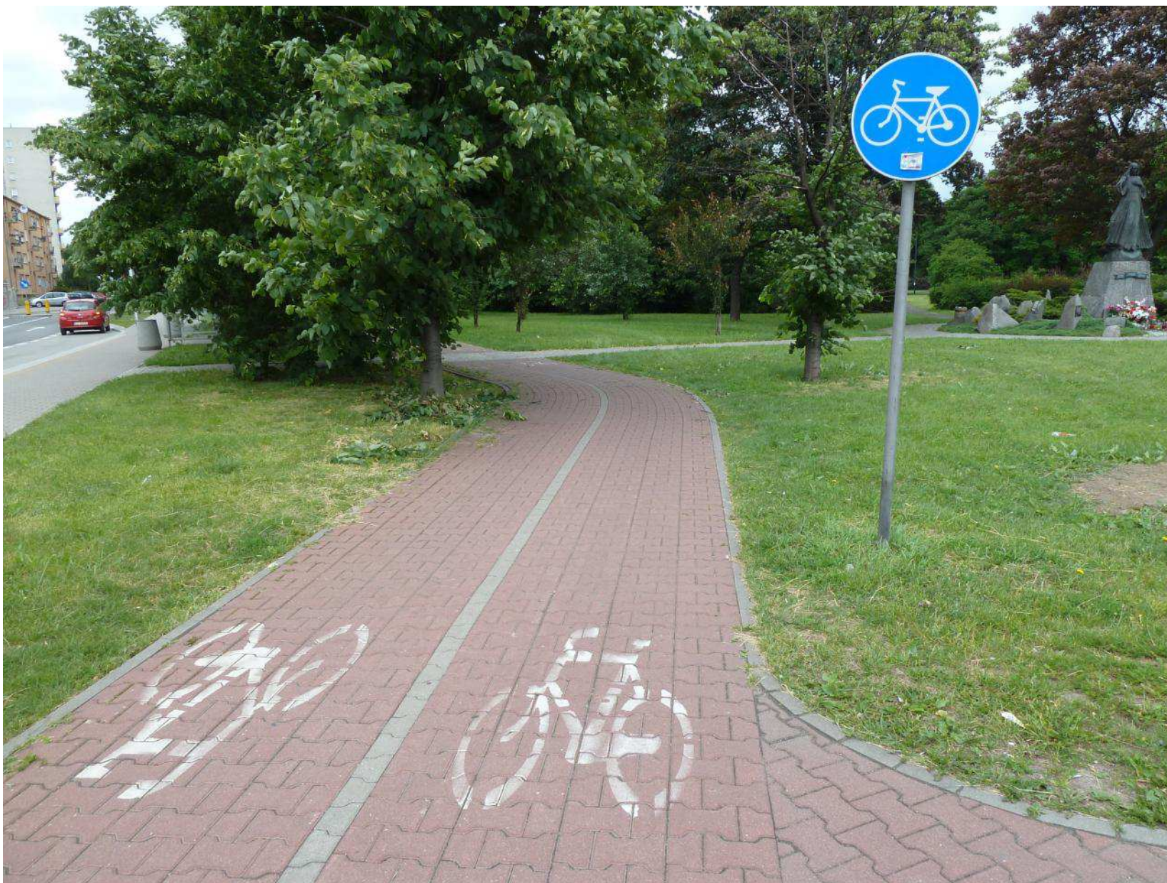
Prosty sposób separacji kierunkowej w przekroju drogi dla rowerów.
