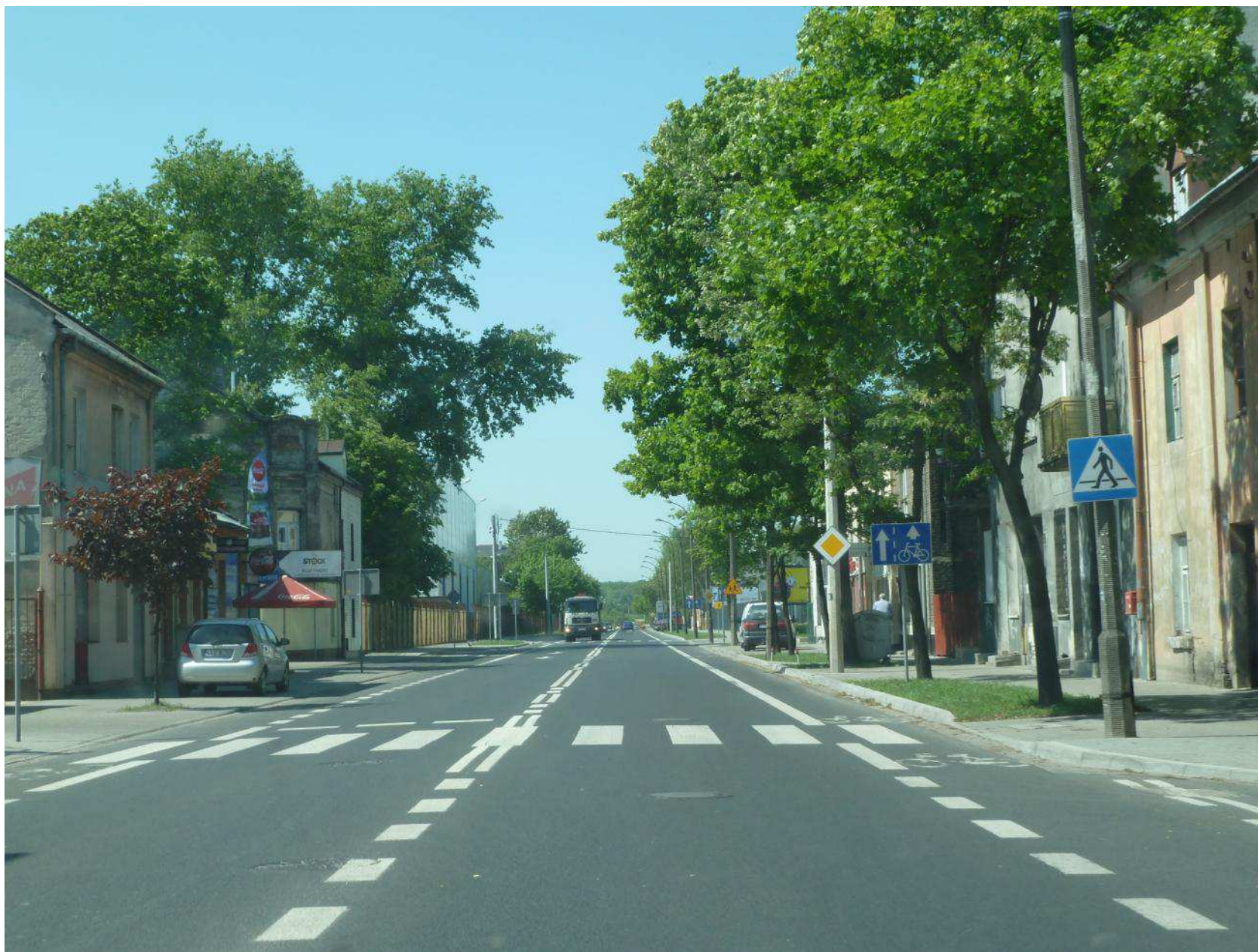
Przykład zagospodarowania przekroju ulicy o szerokości jezdni 9,0 m – 2x3m + 2x1,5 m.
