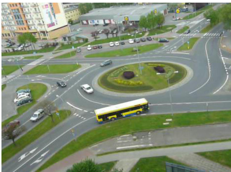
Słupsk Rondo Ofiar Sybiru - przykład turbinowego ronda kierunkowego z 2002 r.
